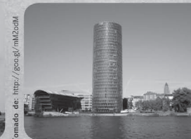
Tomado de: http://goo.gl/mh2caH Torre Westhafen en Frankfurt, Alemania
