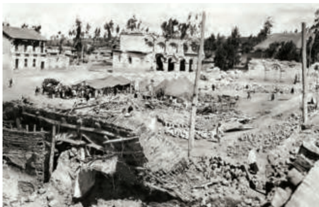
Terremoto de Ambato, 1949
