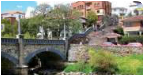
Puente Roto, en la ciudad de Cuenca.
