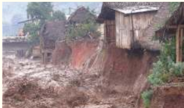
Viviendas en riesgo en la Costa ecuatoriana
