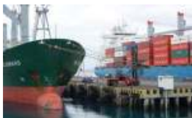
Puerto de Manta
