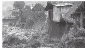
Viviendas en riesgo en la Costa ecuatoriana
